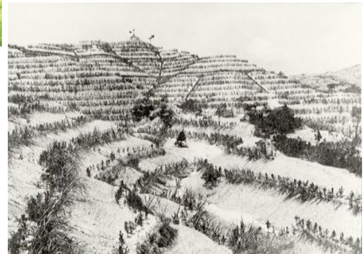
砂防工事着手後1年（明治41年8月）
