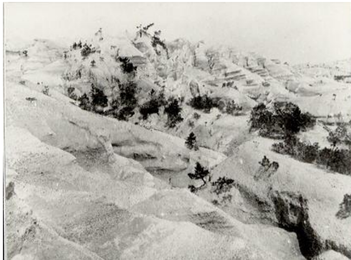
砂防工事着手前（明治40年4月）
