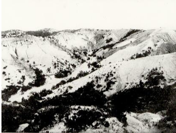
砂防工事前（明治40年8月）
