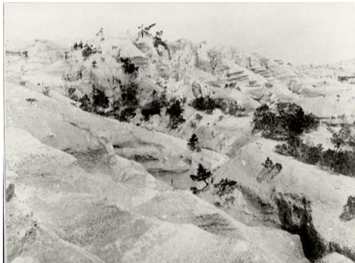
砂防工事着手前（明治40年4月）
