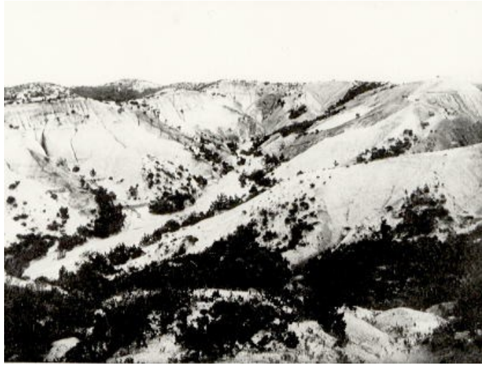
砂防工事前（明治40年8月）
