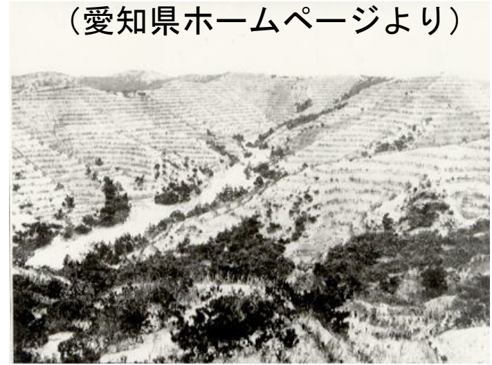
砂防工事後（明治41年10月）
