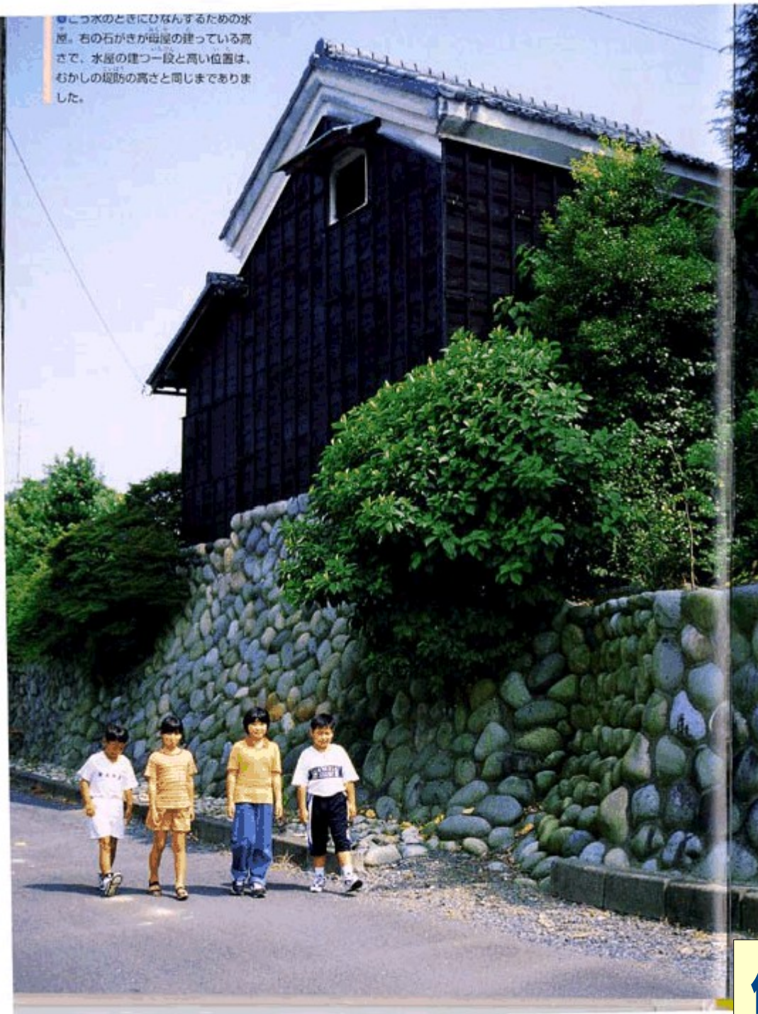
〇家の建築現場。新しく家を建てるまえに、むかしからの家づくりのやりかたを守って、石がきと土盛りで土台を高く作っています。
