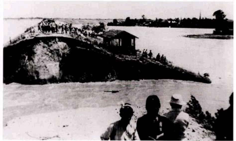
○昭和27年6月24日、長良川右岸の海津郡平田町勝呂の堤防が切れました。ダイナ台風による集中豪雨のすさまじい破壊力のつめあとです。2108戸が浸水しました。
