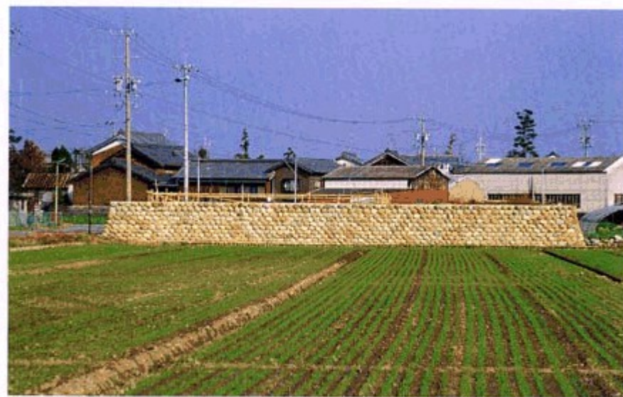
〇家の建築現場。新しく家を建てるまえに、むかしからの家づくりのやりかたを守って、石がきと土盛りで土台を高く作っています。
