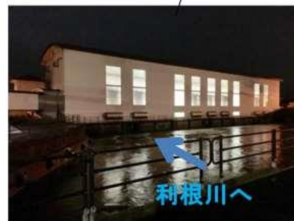
印旛機場から利根川への排水状況（10/13 1:00）
