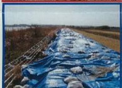
堤防亀裂、すべり、崩落、沈下 L≒400m
