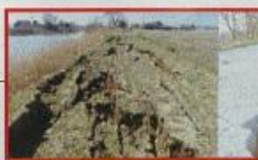
旧長門川堤防全面崩落 L=200m 長門 H
