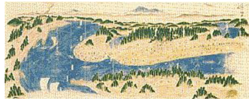
赤堀川開削の様子
