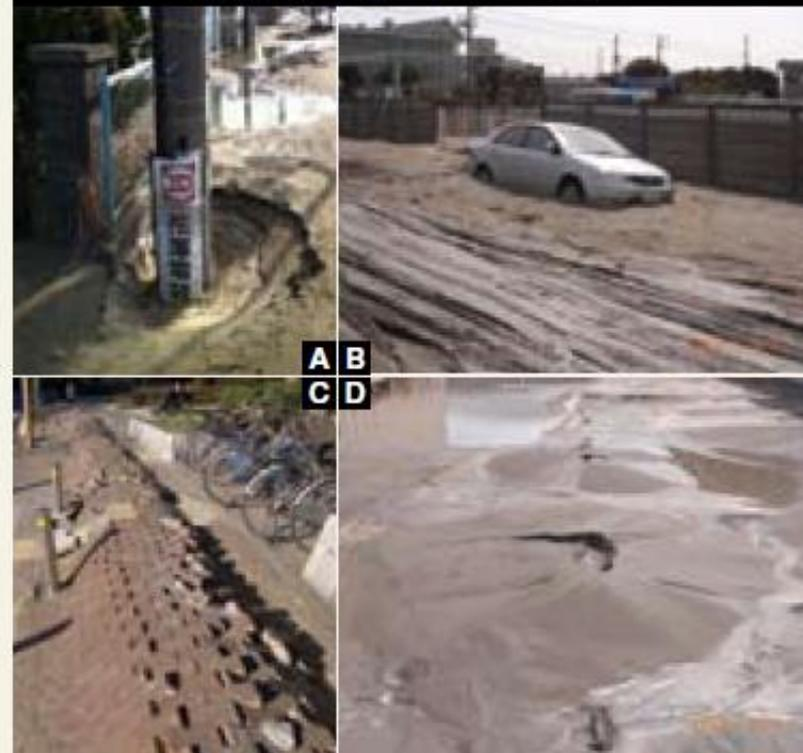
**A** 電柱が約 1m 沈下 **B** 噴砂に埋もれた車 **C** 盛り上げる歩道のブロック **D** いくつもの噴砂丘が残る
