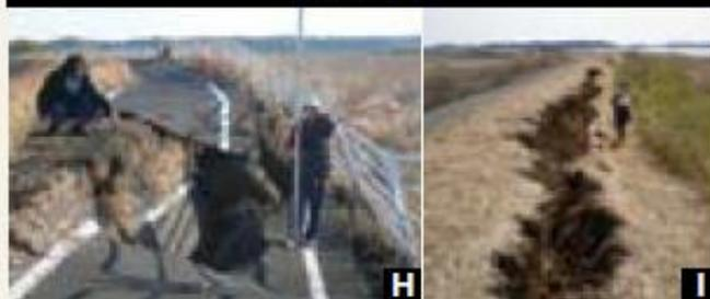
**H**、**I** 北印旛沼ではサイクリング道の一部で、亀裂や崩落、沈下といったことが起きた。
