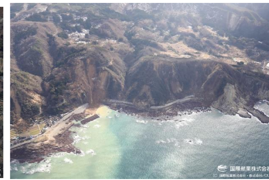
珠州市国道249号線沿の崩壊（国際航業・パスコ）
